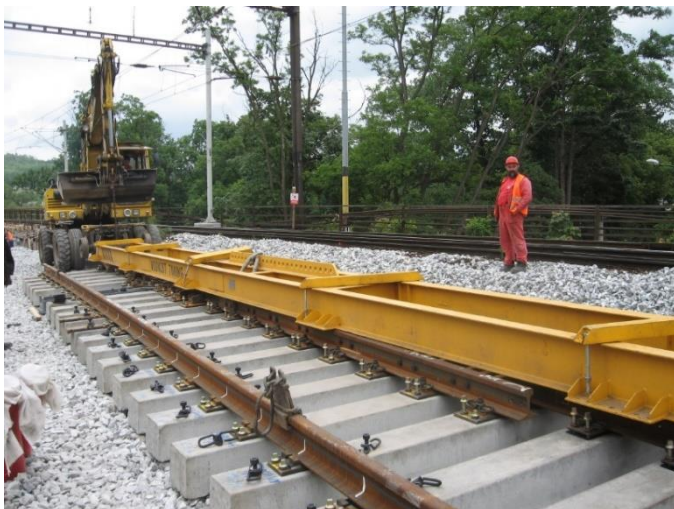
Obrázek 6 - Montáž samostatné srdcovkové části se srdcovkou s PHS
