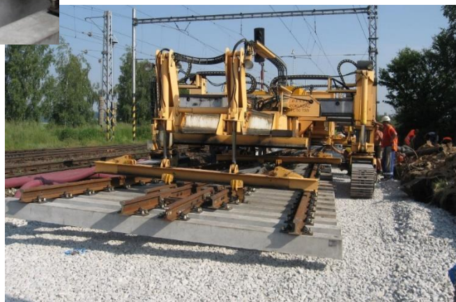
Obrázek 7 – Pokládka srdcovkové části se srdcovkou s PHS
