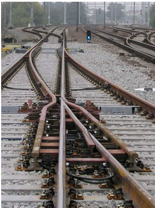
Obrázek 1 – Srdcovka s PHS v provedení s rámem z kolejnic
